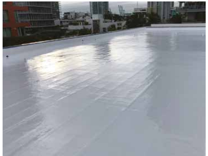
7870 Capa superior HSS en un techo de betón modificado
